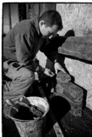
Olivier Doublet , enseignant en Bac PRO Intervention sur le Patrimoine Bâti au lycée Victorine Magne à Lisieux. (© S.JANOU/PAE)
